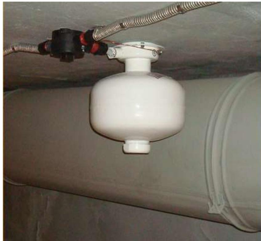
Система автоматического порошкового пожаротушения на основе модулей Буран-2.5
